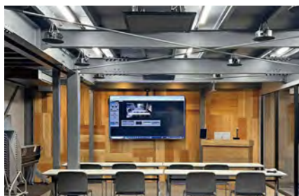
企業の多目的ホールに設置した会議システム
