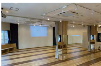
レンタルスタジオへ設置した音響設備
