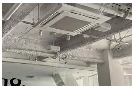
カフェに設置した音響設備
